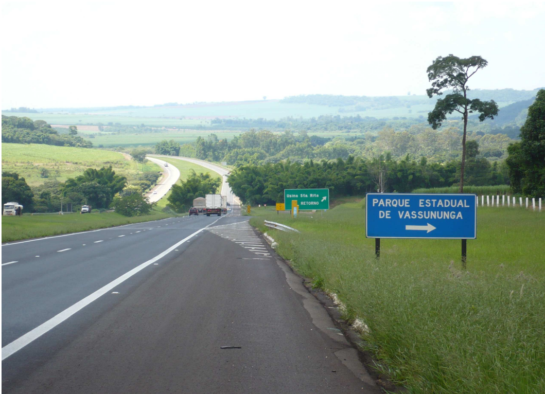
Figura 54 – Placa de sinalização na área de domínio da Rodovia Anhangüera – Pista Sul, km 245 + 500 m.
