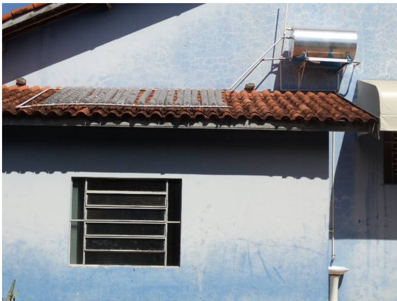
Vista frontal do aquecedor solar de garrafa PET, demonstrando as placas coletoras.
