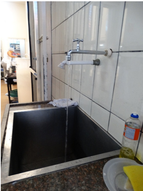
Vista da torneira com água quente utilizada para a limpeza.
