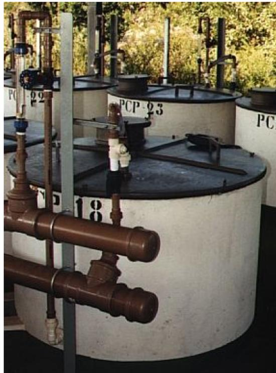
Figura 3: Biorreatores com sistema de aeração forçada para tratamento de 400 Kg de solo por unidade
