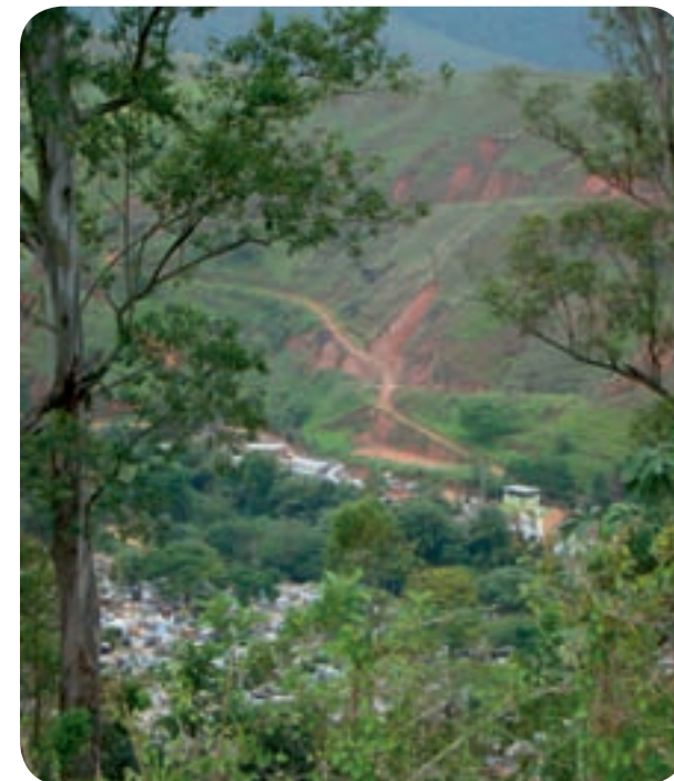
Figura 3.16 – Processo de erosão deflagrado pela movimentação de terra e pela degradação da vegetação natural, município de Aparecida.
