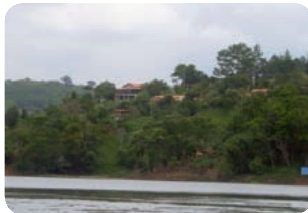
Figura 3.25 – Residências em construção, próximo à área de remanescentes florestais, no município de Jambeiro, no reservatório Santa Branca.
